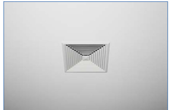
Inbouw in gesloten plafond
